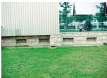
使用沉台方式地层处理后的冷库室外侧
