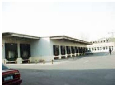
以小车码头为主的大小车码头搭配设计 (大车停靠区域下挖35厘米)
