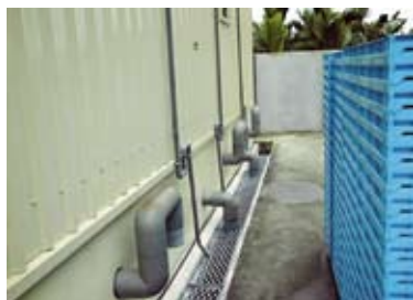
使用PVC管处理及依规则地层处理后的冷库室外侧
