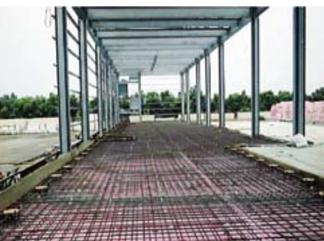
XPS板上层扎筋时防撞杆及防撞角铁的预埋
