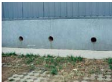
使用预埋水泥管方式地层处理后的冷库室外侧
