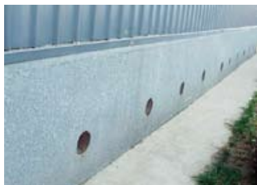
使用预埋水泥管方式地层处理后的冷库室外侧
