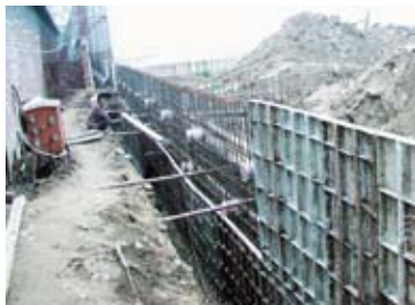
基础地梁处理
