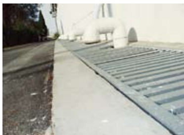
使用PVC管处理及依规则地层处理后的冷库室外侧
